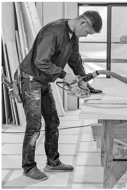
後藤幹事の作業の様子
