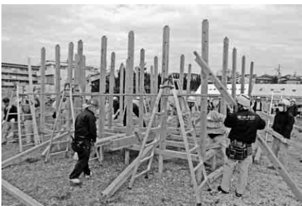
手分けして応急仮設木造住宅作り
