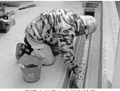
側溝を工事する岩寄幹事
